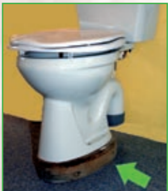
Rehausse placée sous le wc.
